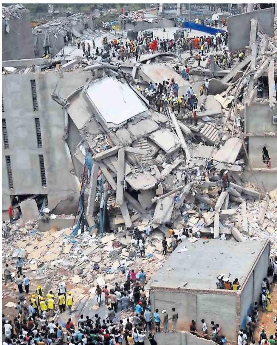
Massengrab: Beim Einsturz der Textilfabrik Rana Plaza in Bangladesch verloren 1136 Menschen ihr Leben, mehr als 2500 wurden verletzt.
